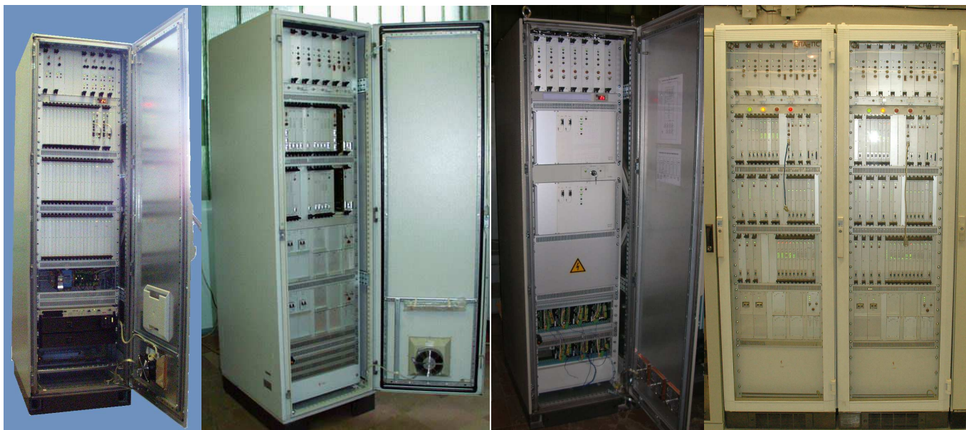
Рисунок 8 – Возможные варианты компоновки программируемых контроллеров, реализованных на технических средствах СПА-ПС
